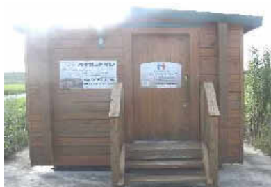
トイレ。排水を出さないバイオ トイレ(おがくず式)でした。
