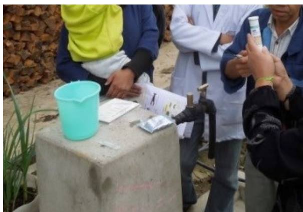
写真 23 St.1 行政事務所の外水道。手前のコンクリート製枠で立ち上げている外水道である。
