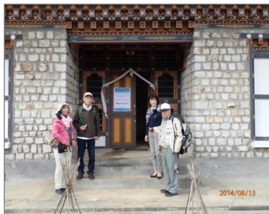
写真12 行政事務所の入り口。中に林業、農業、畜産事務所がある。新しい役所もブータンの伝統の様式が取り入れられている。
