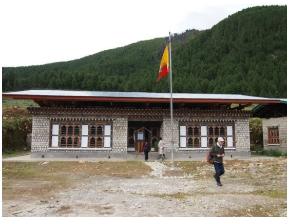
写真3 ポプジカ村に新設された行政事務所。森林・農業・牧畜の3つの部門が入っていた。
