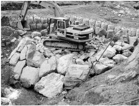
図5 流側水制工. 2段石積状況
