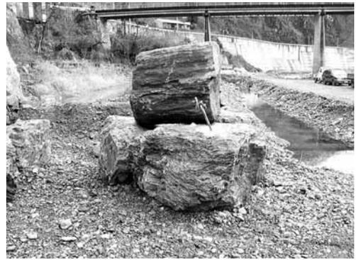
図6 置石工. 巨石を金具で連結し据付た状況
