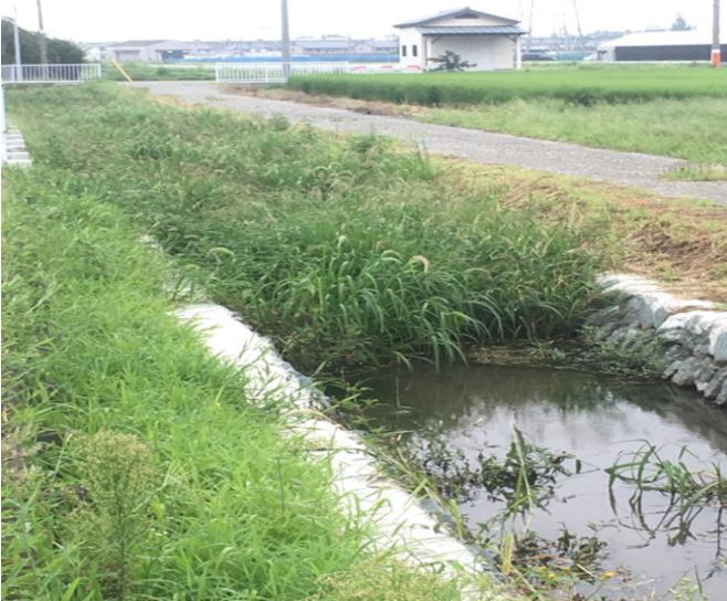
下がり川工事後
