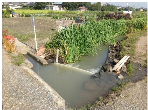
写真2 旧岡之郷堰からの取水地点 板の抜き差しで水量の調節をした
