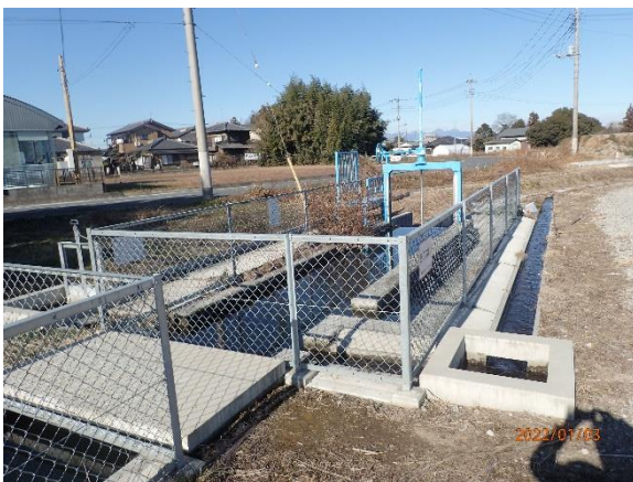
写真1 岡之郷堰下の新分土工
